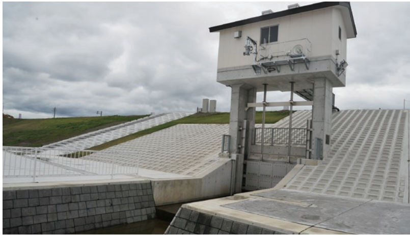
保田川の水を取り込む「内水取入樋門」
