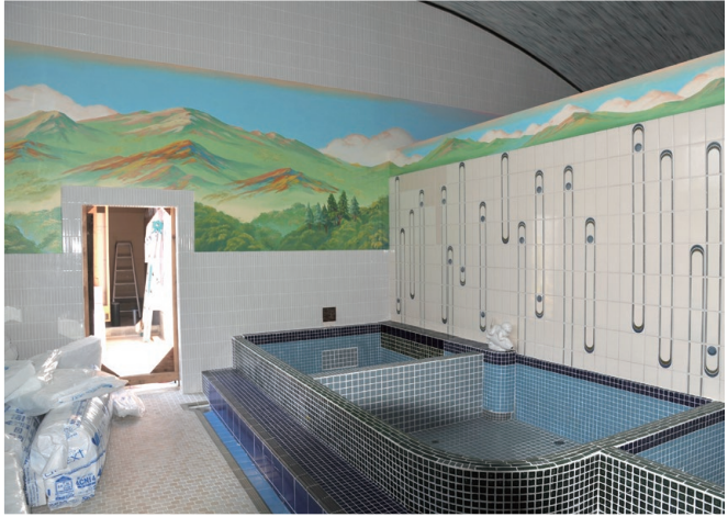
開業に向け、改装が進む浴槽、奥にはサウナが設置される
