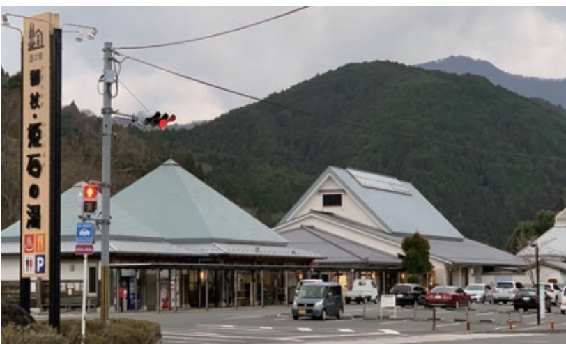
来年度中に薪ボイラー2基が導入されることになっている「道の駅御杖・姫石の湯」
