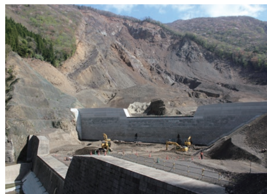
プログラミング制御された重機を使い施行中の赤谷地区の3号砂防えん堤
